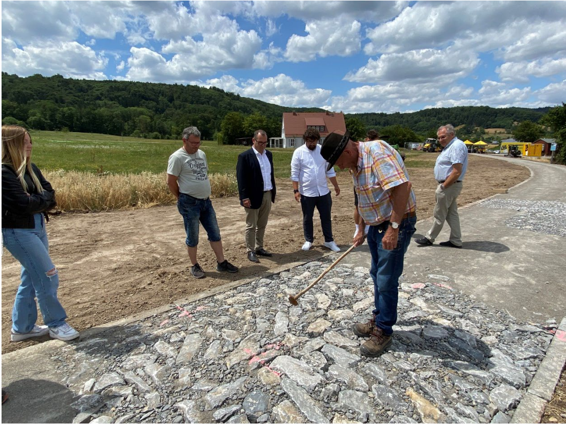
Heinrich Eichele Sen. zeigt auf, wie die Chaussierung durchgeführt wurde.
